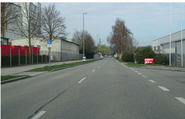
Abb. 39: Qualitativ unzureichende Sicherung des Radverkehrs: Gehweg Radfahrer frei (links); Netzlücke: Nicht befahrbarer Netzabschnitt (rechts)
