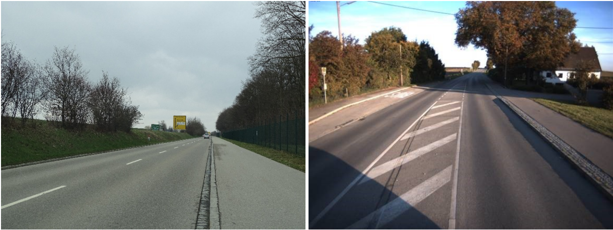
Abb. 57: Fehlender bzw. nicht markierter Sicherheitsraum zur Fahrbahn (links); Sicherheitsraum zur Fahrbahn wurde nachträglich markiert (rechts)
