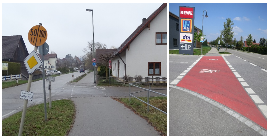
Abb. 51: Erneuerungsbedürftige Furtmarkierung (links) und Furtmarkierung roteingefärbt und mit integrierten Fahrradpiktogrammen (rechts)
