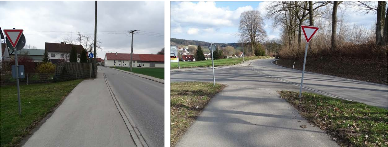
Abb. 53: Fehlende Überleitungen und Querungshilfen am Ende eines 2-Richtungsradweges. Zusätzliches Sicherheitsrisiko bei Kombination mit einer Kreuzung (rechts)
