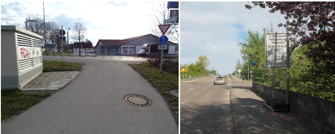
Abb. 52: Stark eingeschränkte Sicht an Kreuzungen durch Einbauten und Bewuchs
