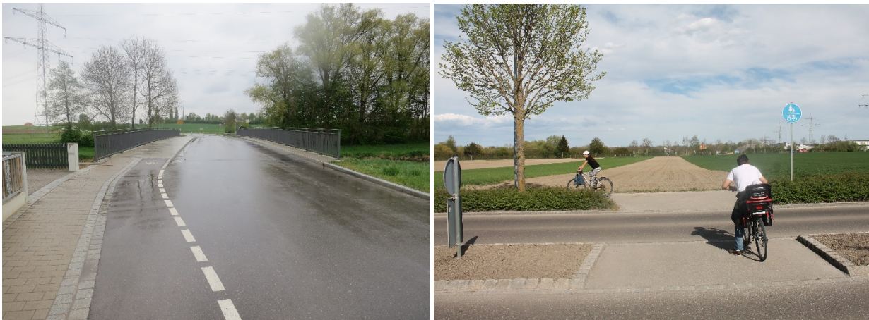
Abb. 54: Bauliche Überleitung mit Rückenschutz (links); bauliche Querungshilfe (rechts)
