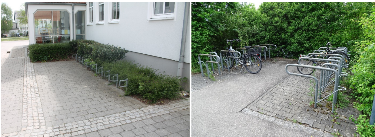
Abb. 66: Nicht mehr zeitgemäße Felgenhalterungen (z.T. beschädigt) und komfortable Einschubrahmen
