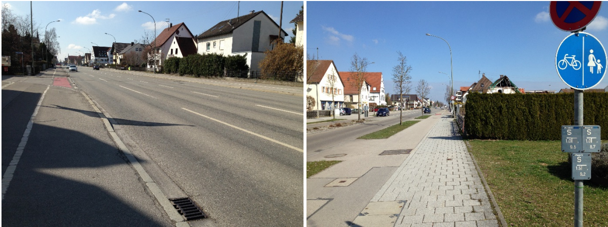
Abb. 55: unzureichende Trennung zum Gehweg (links); taktil erfassbare Trennung zum Gehweg (rechts)
