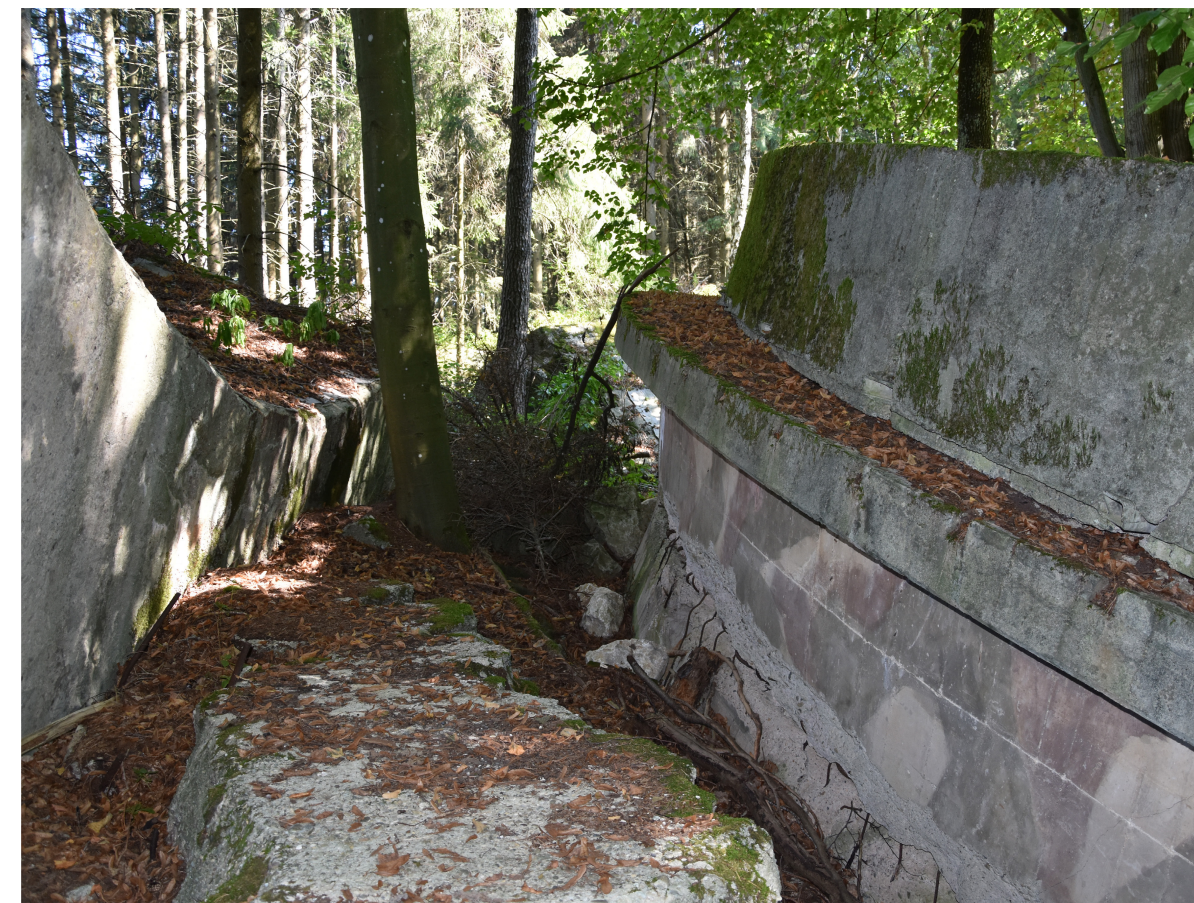
Reste der Methanolbunker mit Tarnfarbe
