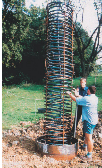
Einbau eines »Ökopfahl-Kollektors« in die mittels Mantelrohr stabilisierte Greiferbohrung.
