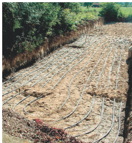
Einbau eines Kapillarrohrmatten-Erdwärmekollektors bei einem Neubauprojekt.
